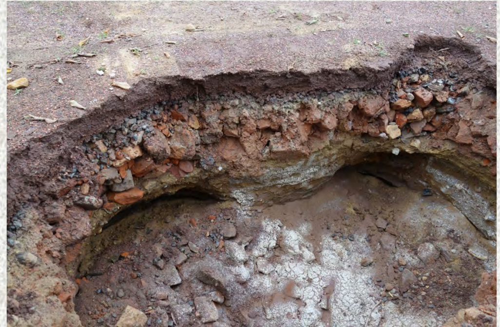
Aufbau vor Ort (Baggerschurf)
