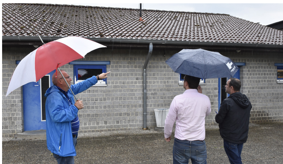
Begutachtung der Dächer des TSV Isernhagen für eine mögliche Photovoltaikanlage. Foto: LSB
