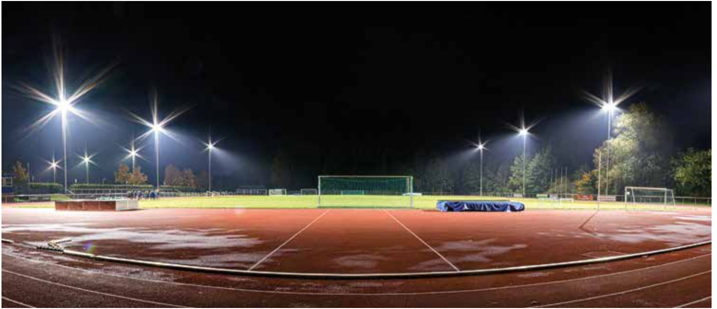
VfL Stade (Stade) - Errichtung einer Flutlichtanlage im Leichtathletikstadion. Foto: Joerg Struwe
