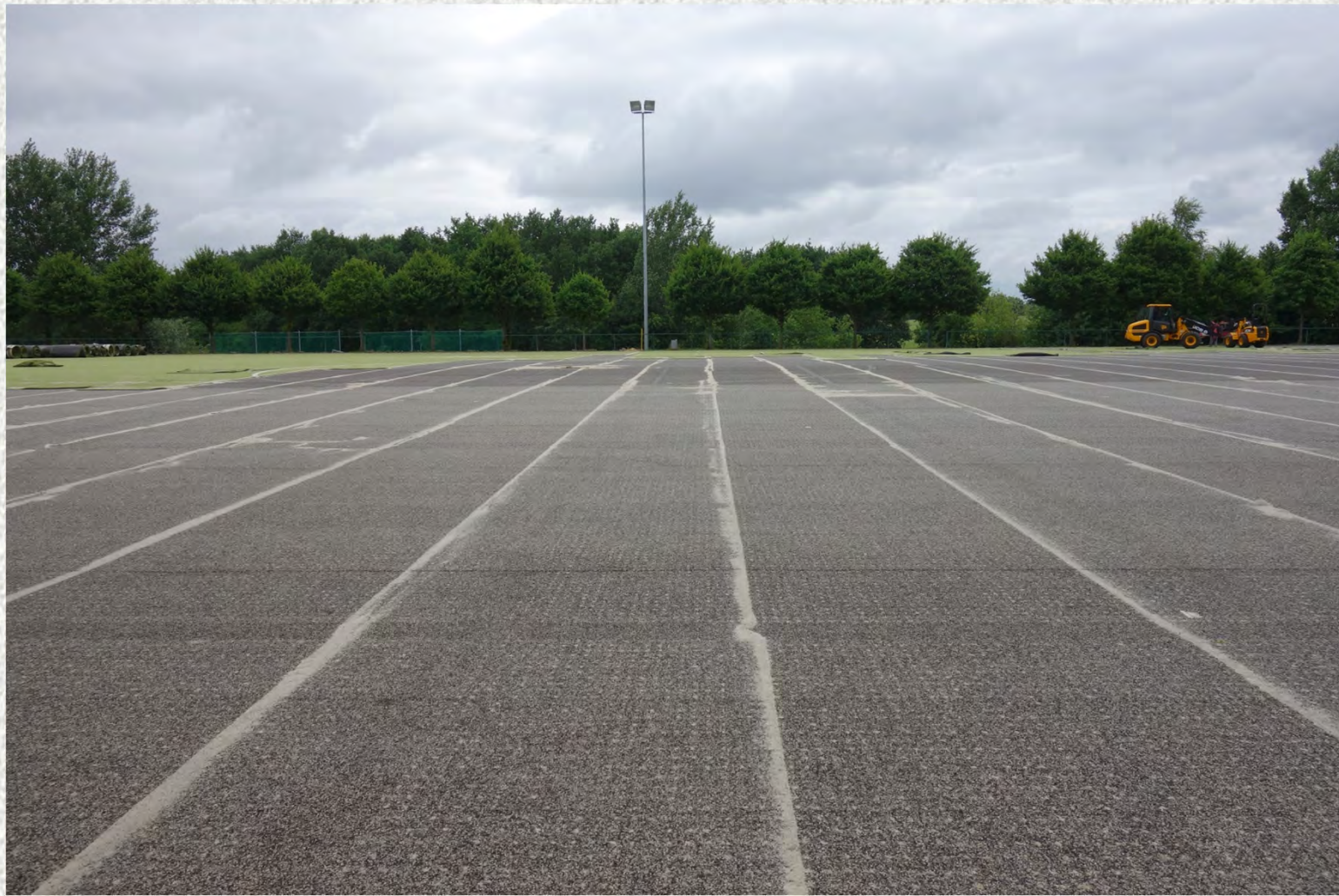
Spielfeld nach Rückbau KuRa und vor Grobreinigung
