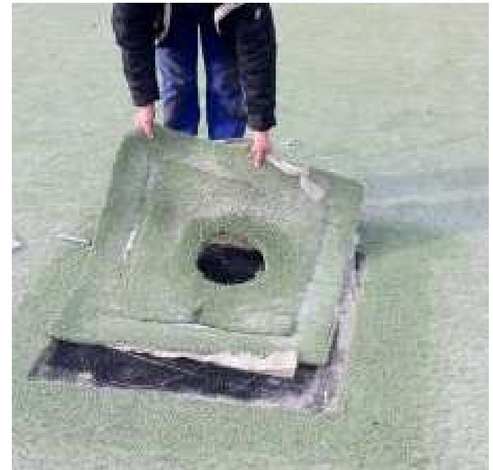
...und die Reparatur !
