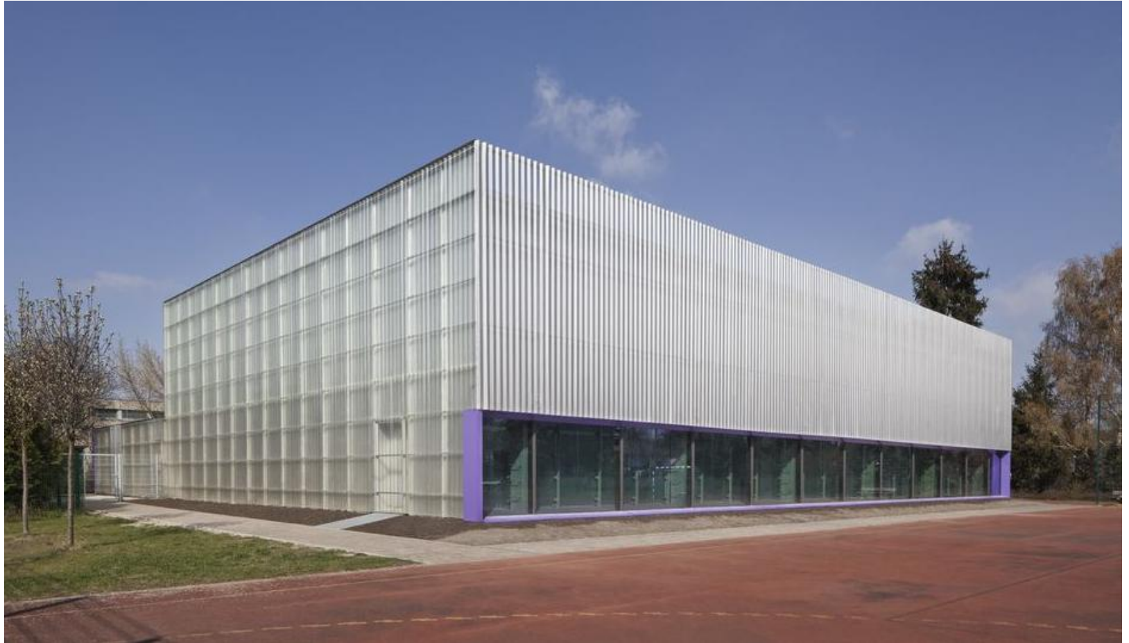
Sanierung Sporthalle am Dielingsgrund , Augustin und Frank Architekten Berlin
